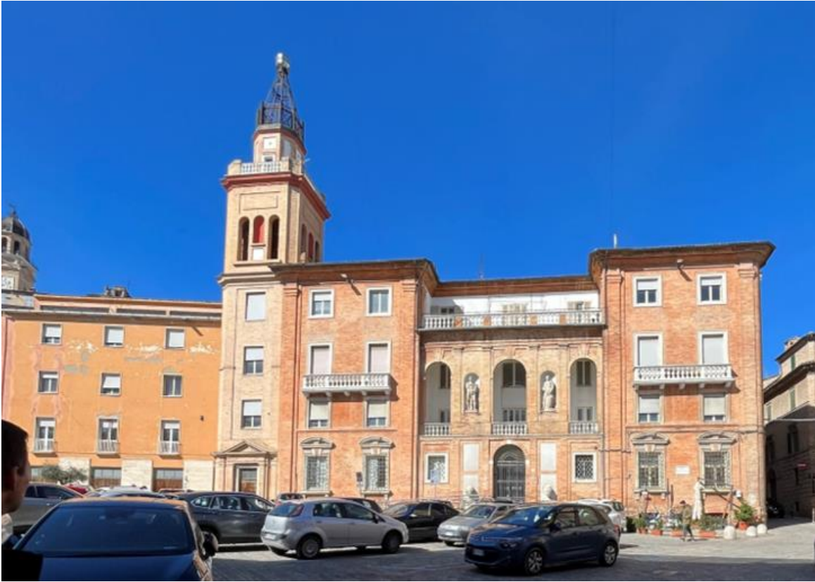
Ex Casa del Fascio, prospetto su Piazza Mazzini
